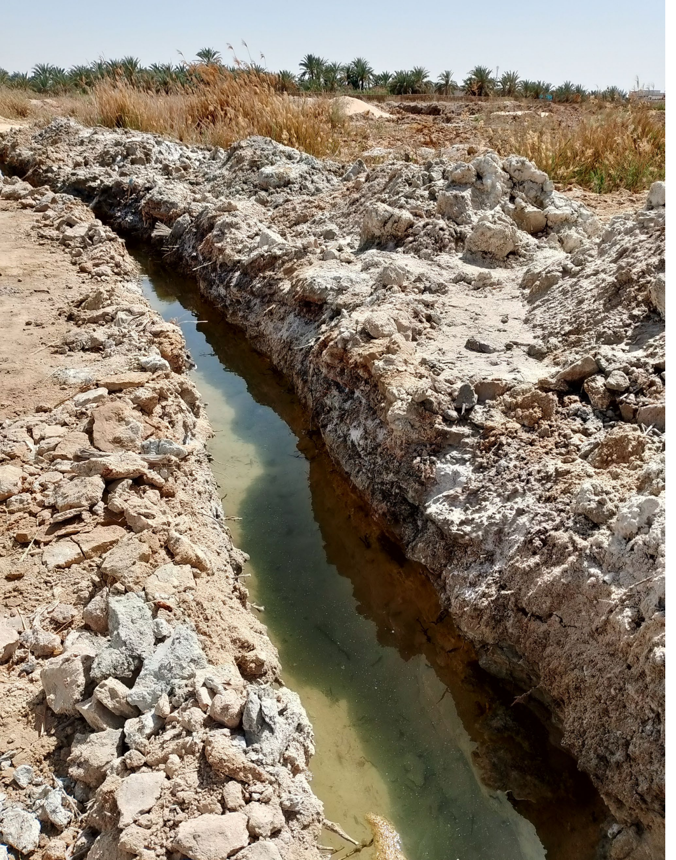
من نفس الموقع، المياه الجوفية في حُفَر حفرتها البلدية مؤخرًا لمد خطوط الضغط العالي (شبكة الكهرباء) لكن غمرت المياه. أبريل 2024 © المؤلفان
