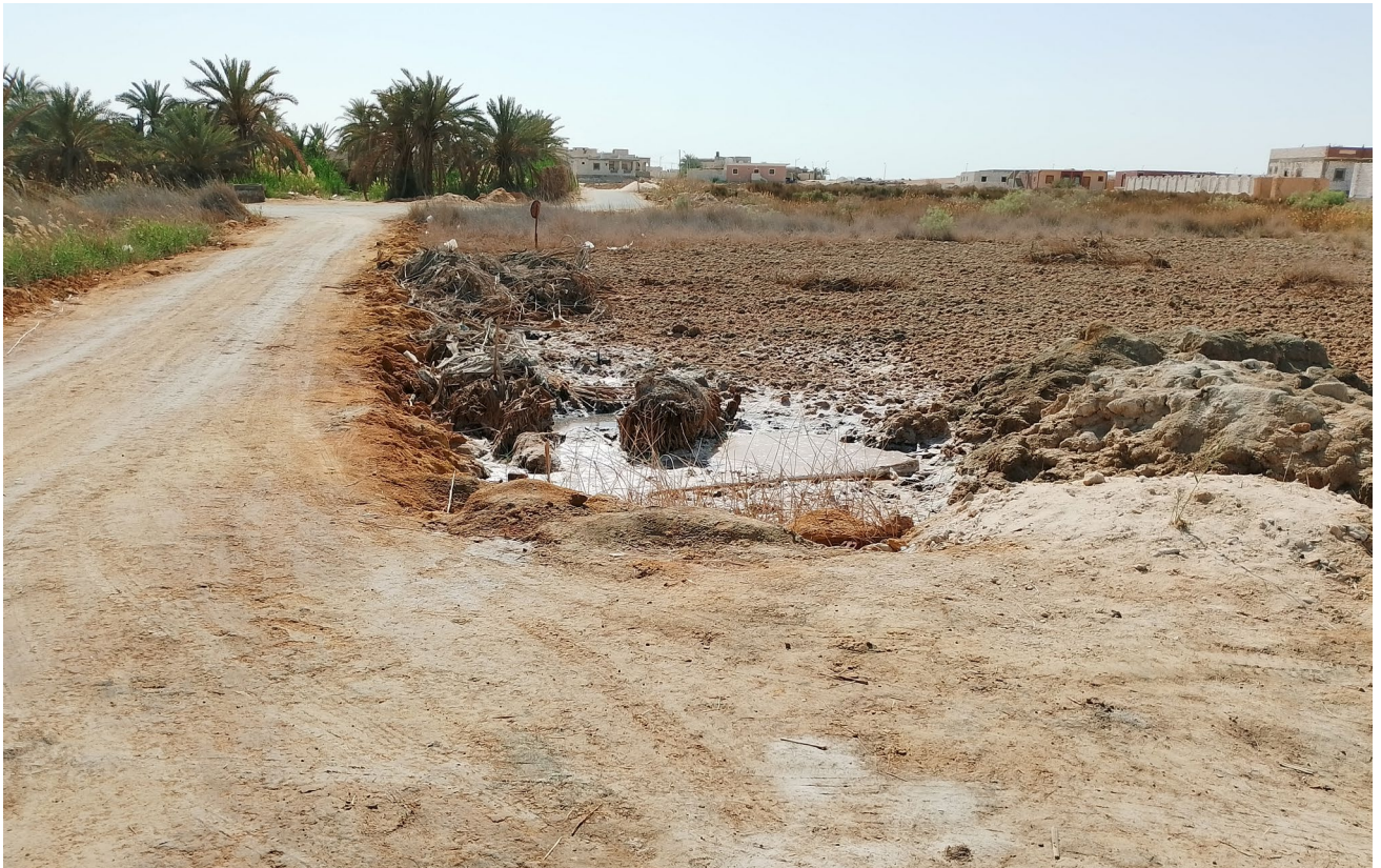
مياه جوفية مالحة أفسدت إمكانية الإنتاج الزراعي في بعض الأراضي، 2 كيلومتر جنوب شرق مدينة سيوة. أبريل 2024 © المؤلفان
