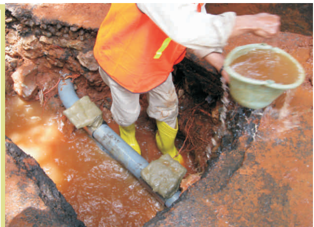
Un ouvrier répare une canalisation d'eau qui fuit dans le centre de Jakarta
